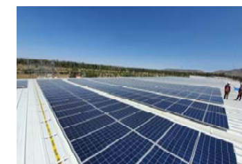
ソーラーパネルの設置 (VIAM Manufacturing Mexico S.A. de C.V.)
