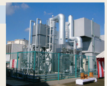
天然ガスコージェネレーション(小山化学)
