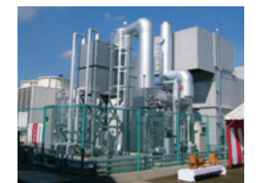
天然ガスコージェネレーション(小山化学)
